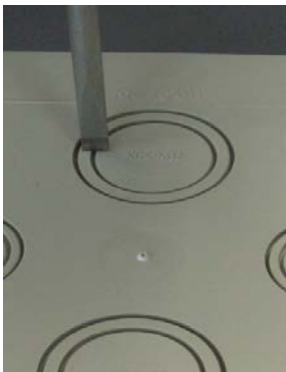
Imagen 2: Destornillador en el borde: posición correcta.
